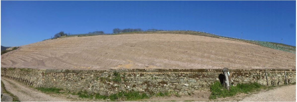
Abb. 5: Totalrodung kleinstrukturierter Weinterrassen auf dem Assmannshäuser Höllenberg für die Neubestockung in Querreihen-Anordnung. – Total clearing of small-structured wine terraces on the Assmannshäuser Höllenberg for replanting in transverse rows. Foto: 05.04.2020
