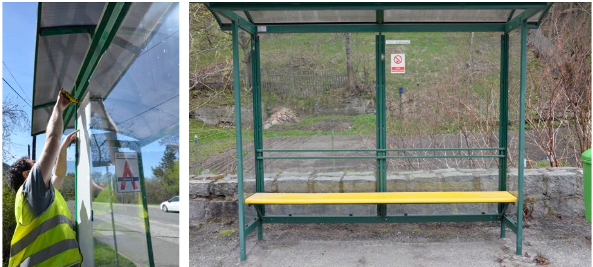
Abb. 2: (A) Die UV-Folie wurde auf der Außenseite der Glasscheiben der Bushaltestellen angebracht. (B) Eine beispielhafte Bushaltestelle, die mit der UV-Folie von BirdShades beklebt wurde (sie ist für das menschliche Auge weitgehend unsichtbar). – (A) The UV film was applied on the outer side of the bus stop glass panels. (B) An exemplary bus stop covered with BirdShades UV film (it is mostly invisible for human eyes).
