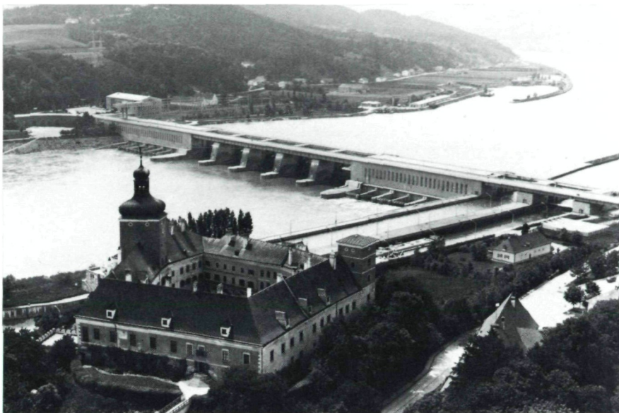
Abb. 14: Donaukraftwerk Ybbs-Persenbeug (Gesamtansicht). Beispiel einer gelungenen Einbindung in die Landschaft.
