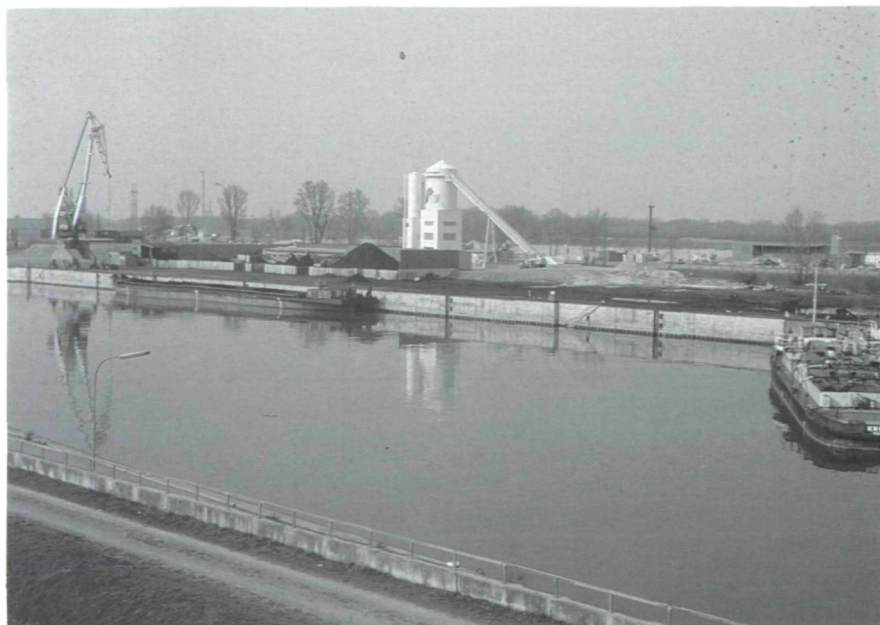
Abb. 2: Hafenanlage in Wien mit strukturlosen, verspundeten Ufern (Foto: Zauner)
