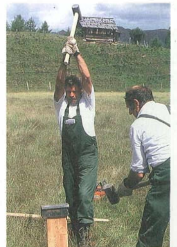
Dämme aus Lärchenholz halten das Wasser im Moor zurück.
