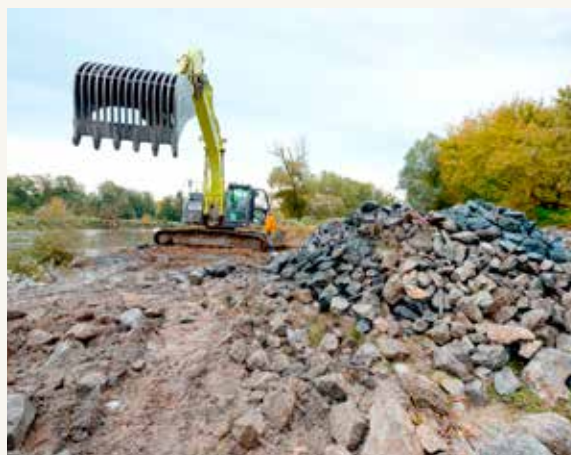
Harte Uferverbauungen werden per Bagger entfernt.
