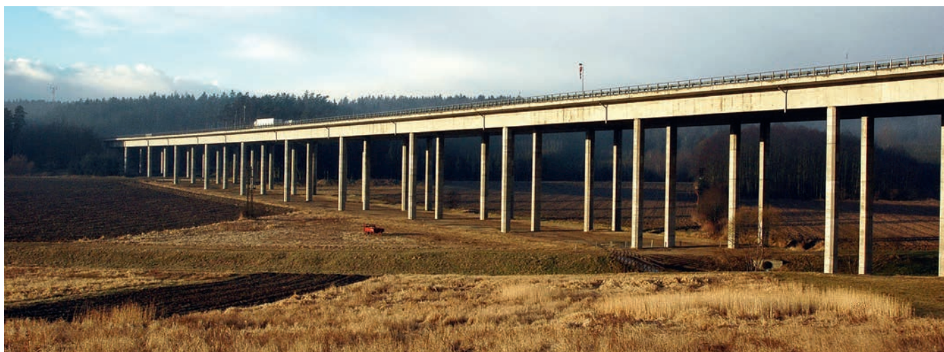
Abbildung 13. Technische Bauten, wie Talüberführungen, eignen sich häufig sehr gut als Wildtierpassagen. Autobahn A2.
