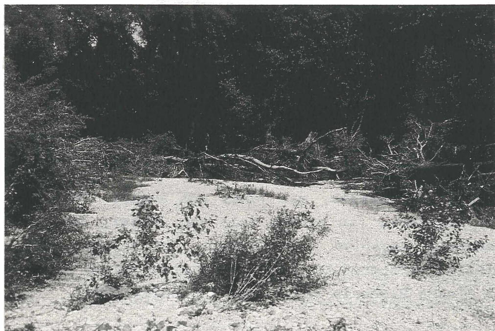
Mitterhaufen - Vom Hochwasser entwurzelte und angeschwemmte Bäume; mächtige Anlagerung von Schottermaterial im Vordergrund erkennbar.
