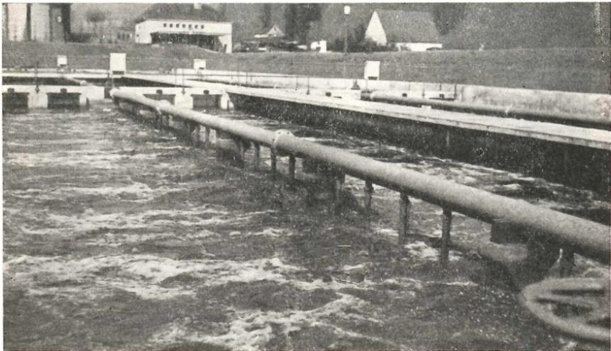
Abb. 14. Belebtschlammanlage Buchenhofen
