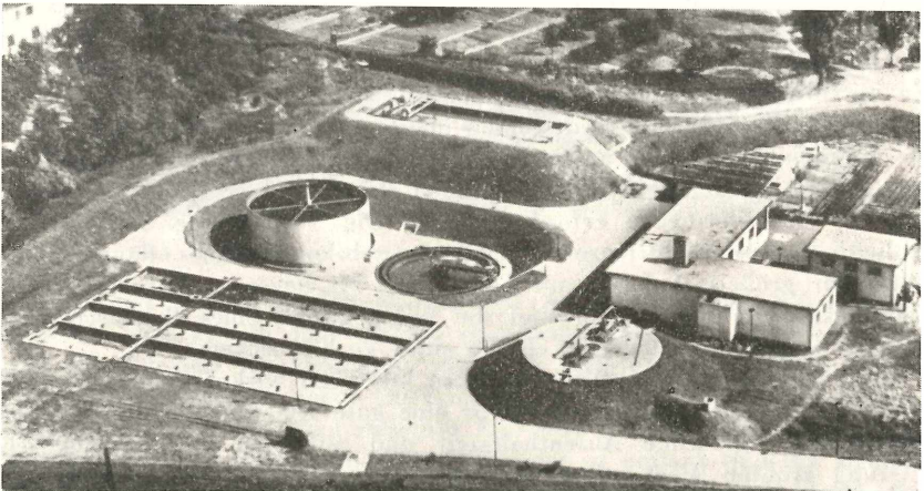
Abb. 8. Kläranlage Goldstein, Frankfurt
