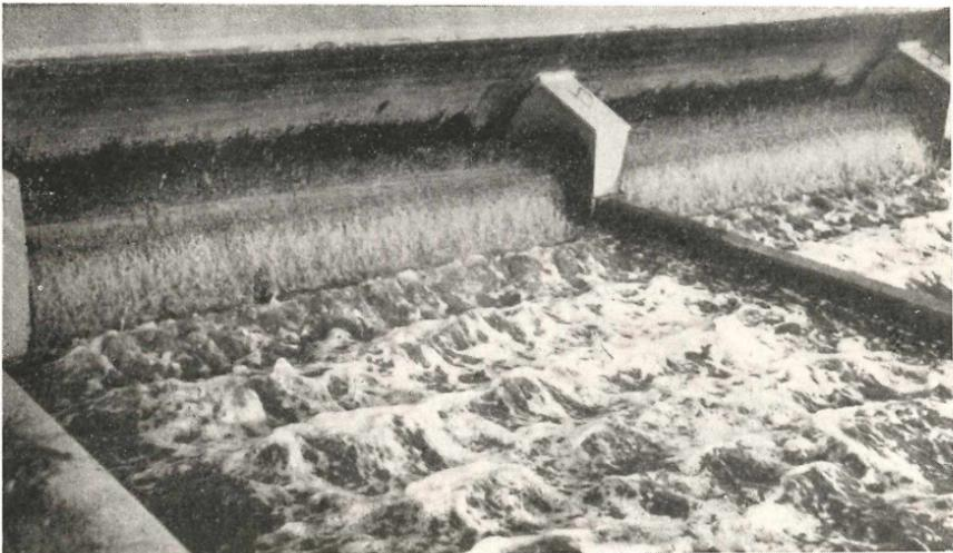
Abb. 19. Belebtschlammanlage mit rotierenden Bürsten
