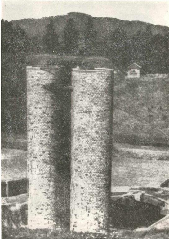
*Abb. 11. Ansicht des Turmtropfkörpers
