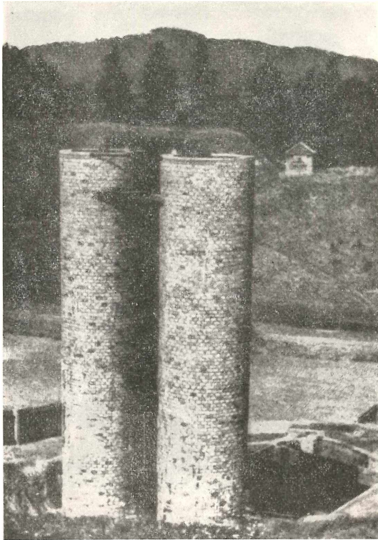
Abb. 11. Ansicht des Turmtropfkörpers in Bad Berka (nach Lang 13 )
