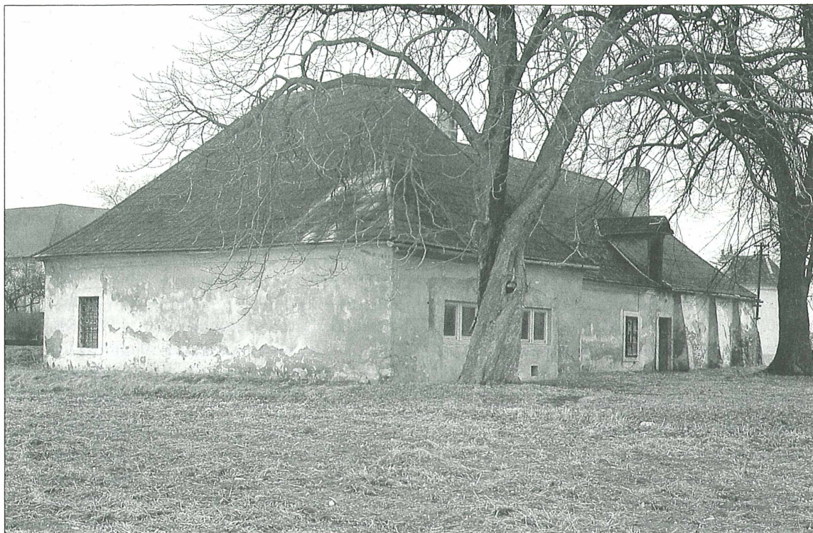
Abb. 2: Das Neudörfler Krügerhaus in der Wiener Neustädter Straße.
