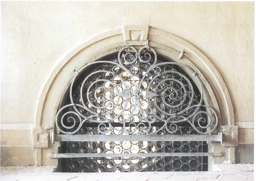
Abb. 3: Durch bauliche Erweiterung 1643 verstelltes Ostfenster der Kapelle
