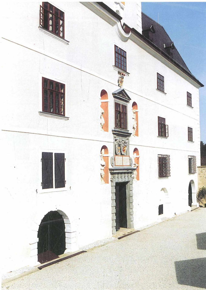
Abb. 5: Die im Jahr 2000 restaurierte Ostfassade
