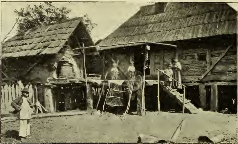
Fig. 2. Pfahlbauhaus mit Walmdach „na dumu“ und Nebengebäude für ein junges Ehepaar in Gornja Dolina.
