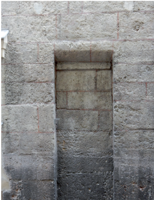
Abb. 38: Seilergasse 1, Erdbebenstützpfähler mit weißer Schlämme und aufgemalter Quadrierung mit rotem Fugenstrich, 2017. Foto: Reinhard Rampold.
