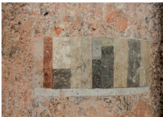
Abb. 32: Burggraben 3, alte Hauptwache, Breckiasäule mit Schichten-treppe, 2017. Foto: Reinhard Rampold.
