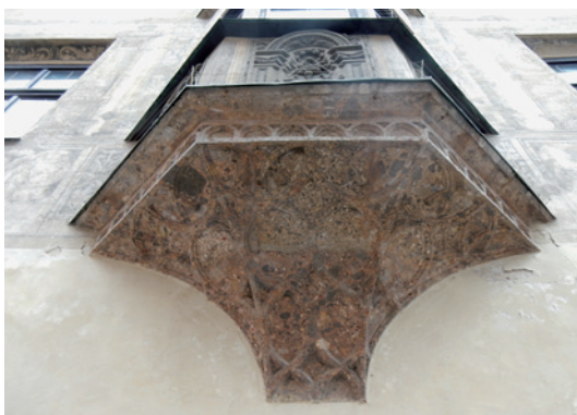
Abb. 29: Herzog-Friedrich-Straße 22, Trautsonhaus, Erkeranlauf ohne Schlämme, 2017. Foto: Reinhard Rampold.
