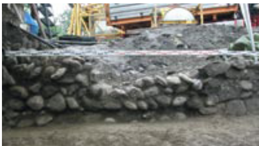
Abb. 12: Wörgl, GP .236. Zugesetzter Eingang im Südteil von M 5. Blick von NO.
