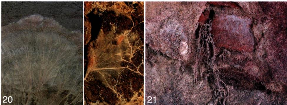
**Abb. 20:** Stränge von *Serpula himantioides* an einer Kellerwand (links) und am Boden einer Werkhalle (rechts), die Stränge treten deutlich hervor. – **Abb. 21:** Stränge von *Serpula lacrymans* in und an einer Wand; Stränge insbesondere im Mörtel.
