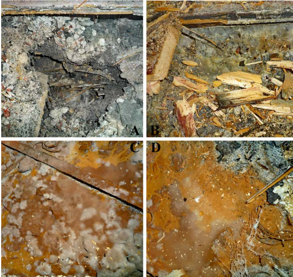
Abb. 1: Befallsbilder von Coniophora prasinoides (vor Ort, frisch), 10.01.2013, Bochum-Wattenscheid (Nordrhein-Westfalen), an Nadelholz eines ungewöhnlichen Fußboden-Aufbaus: Decken-, Bodenfüllung ist Asche auf Lehm Boden mit aufliegenden Schichten aus alten Dielen, Teppich, Spanplatten und Linoleum: A) Asche-, Lehmschicht; B) braunfaule Holzspäne und Mycelien unterhalb alten Dielen, Linoleum entfernt; C) Sporen auf Mycel und Fruchtkörper; D) Sporenstaub auf Strängen und Mycel. Fotos: P. v. D. HEIDE
