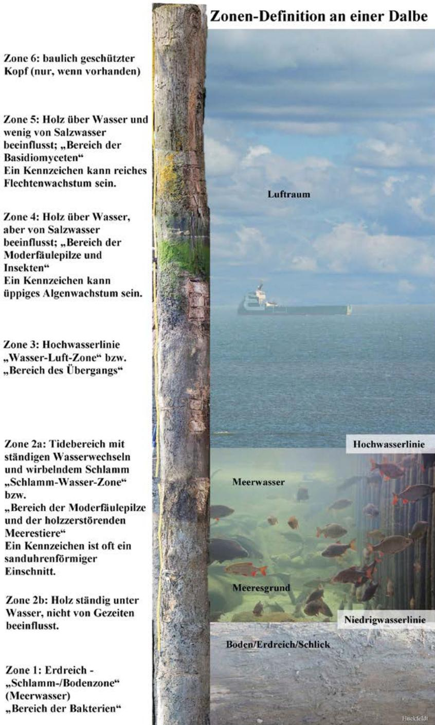
**Abb. 11:** Dalben sind in unterschiedlichen Höhen verschiedenen biotischen Belastungen ausgesetzt; Hauptschaden jeweils genannt (Bildmontage: T. HUCKFELDT).
