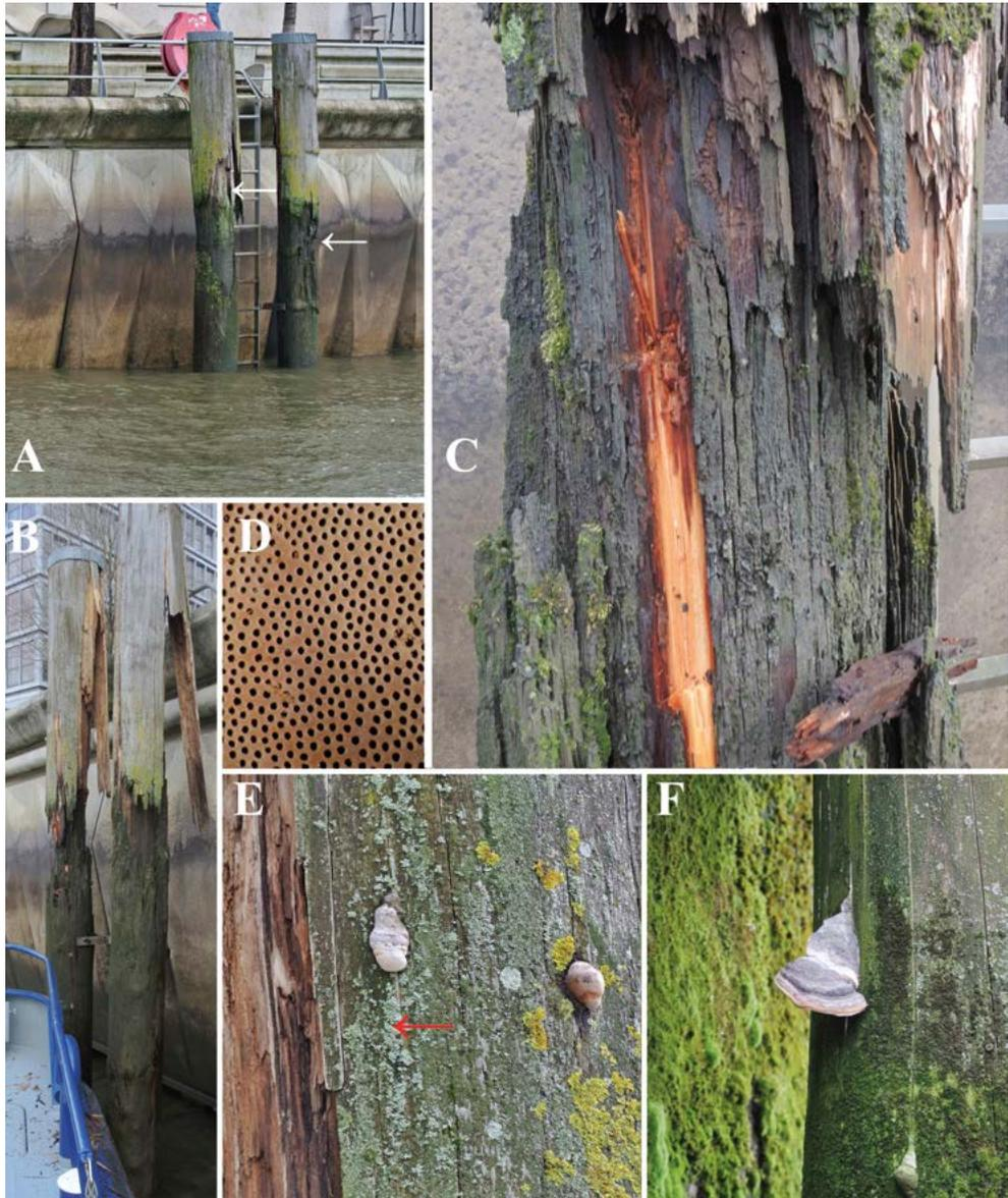
**Abb. 5:** A-F) *Fomitopsis pinicola*, Hamburg, Hafen – Großer Grasbrook, 2. Deko-Dalben (funktionslos), 30.03.2017; A) Übersicht des Fundorts mit Schadbereich über der Tidehubzone (Pfeile); B) Schadbereich der Dalbe; C) Detail des Schadbereiches mit massiver Braunfäule und Insekten Schaden (u.a. Werftkäfer); D) Porenansicht mit 3-4 Poren je mm; E-F) Übersicht Fruchtkörper; Fotos: T. HUCKFELDT
