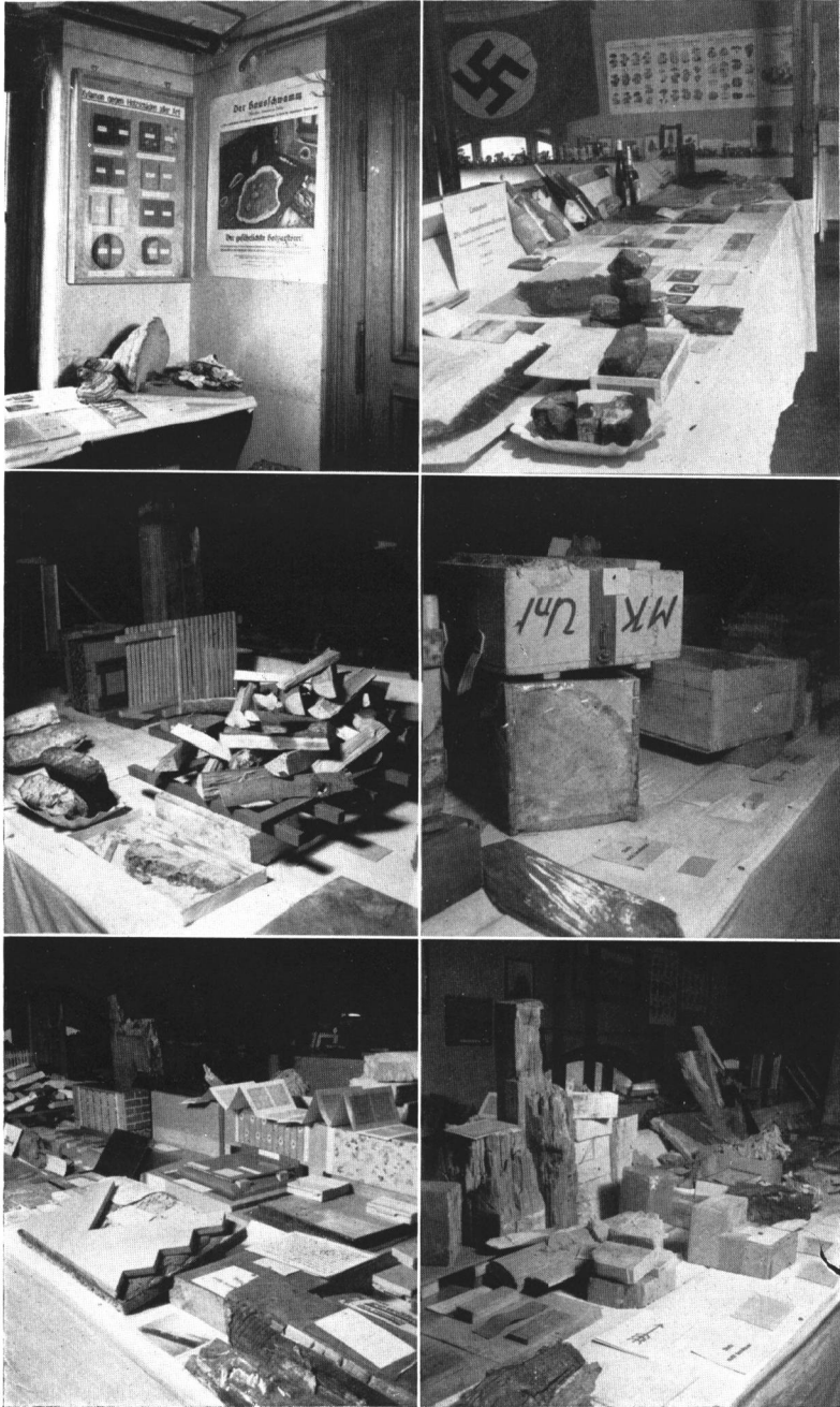
Oben links: Eingang zum Beratungsraum und Ausstellung von Literatur und Frischpilzen. Rechts: Abteilung vom echten Hausschwamm. Mitte: Hausschwamm im Keller an Kisten, Lattenverschlagen usw. Unten links: Schwammsichere Bodenverlegungsarten. Rechts: Hausschwamm in Neubauten.
