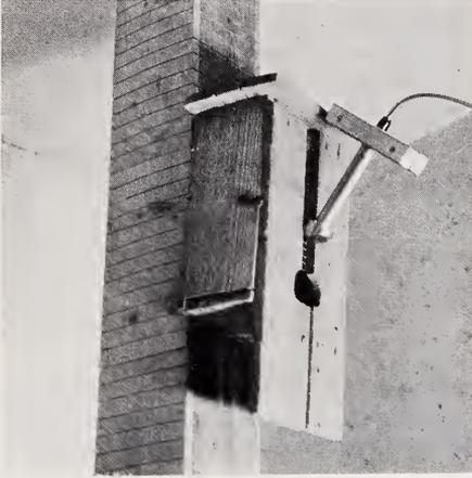
Abb. 1. Kasten mit Schlitz und Mikrophon, erlaubt störungsfreie Aufnahmen
