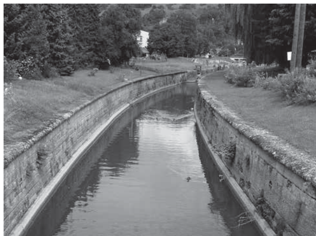
Abbildung 11: Hafencanal zur Donau, W Kelheim, mit Hafenbecken im Hintergrund. Das Mauerwerk besteht aus Grünsandsteinblöcken aus dem Ihrler'schen Bruch. (Foto M. Moser 2016).
