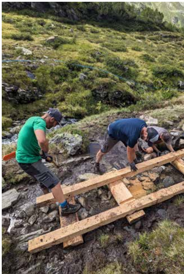
Wegsanierung im Moorkomplex Langsee im hinteren Silbertal. (Foto: RM-ESG)
