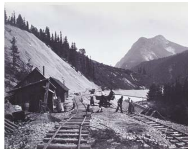
Bauabschnitt Lienzer Klause der Pustertalbahn, um 1870, Foto: Emil Lotze, Bozen
