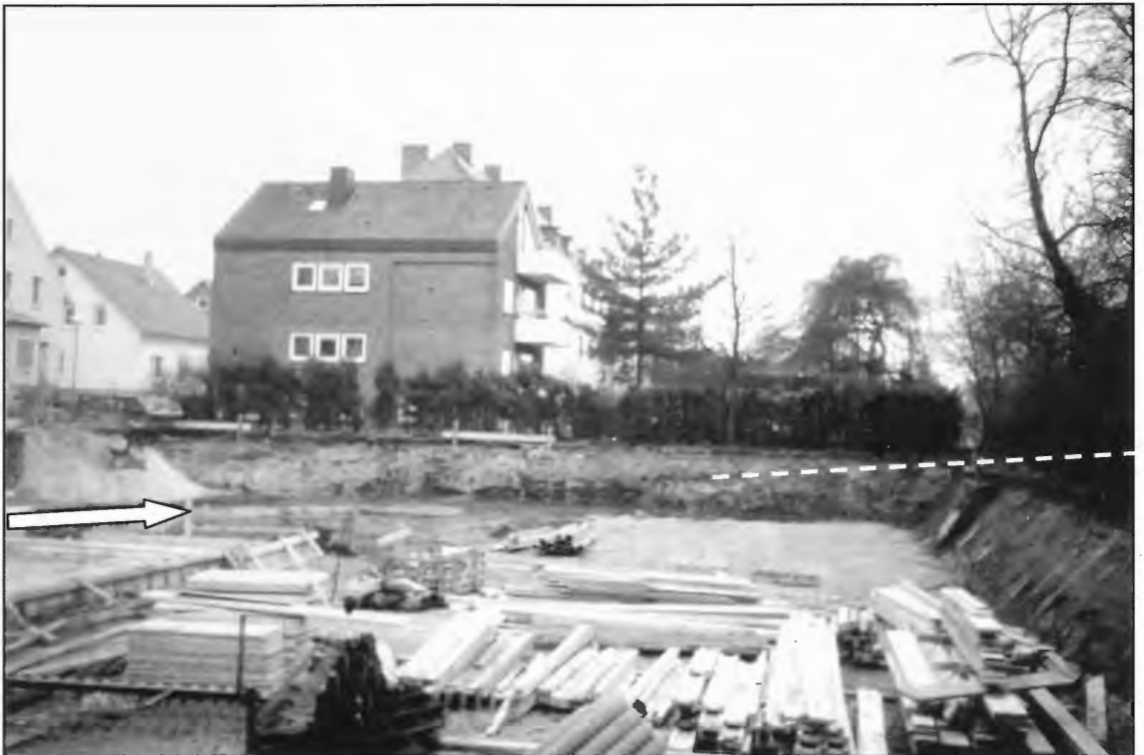
Abb. 3: Baugrube an der Finkenstraße 25 – 29. Links in der aufgelassenen Tonsteinecke (dunkelgrau) ist deutlich die aufliegende oolitische Kalkbank (heller) auf dem Boden zu erkennen (siehe Pfeil). Blickrichtung von Nordwesten nach Südosten. Verlauf der Bank im Anstehenden (siehe gestrichelte Linie).
