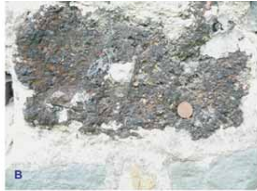
Abb. 77: Raseneisenstein A-B Vreden, kath. Pfarrkirche St. Georg, ehemalige Stiftskirche, Südwand des Langhauses. A Mauerwerksausschnitt, B Detailansicht eines mit kleinen Kieseln verbackenen Bruchsteins, Maßstab 2-Cent-Münze, a Eisenstein, b Bentheimer Sandstein, c Sandsteine der Unterkreide aus dem Raum Vreden-Lünten.
