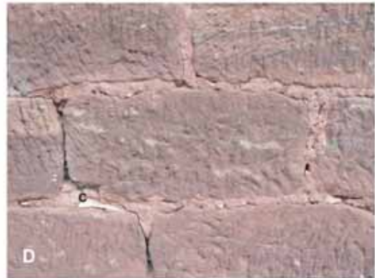
Abb. 24: Gault-Sandstein. A-B Lichtenau, kath. Pfarrkirche St. Kilian, frühes 14. Jh., Turm-Südwestecke, A Untergeschoss, B Wandausschnitt, C-D Herbram, Ackerbürgerhaus Iggenhausener Straße 3, erbaut 1911, C Anbau Nordseite, D Detailsicht. a Gault-Sandstein, b Osning-Sandstein des Eggegebirges, c Plänkalksteine der Baddeckenstedt-Formation, Wambel-Member.
