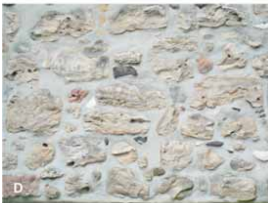
Abb. 34: Sandsteine der Haltern-Formation. A Schermbeck, Wirtschaftsgebäude des Wasserschlosses Schermbeck, B Hamm-Bossendorf, Kapelle St. Katharina, älteste Teile 11. Jh., C Lembeck, westliches Torhaus des Wasserschlosses Lembeck, 1692, D Recklinghausen, Mauerwerkaußschnitt der Ostseite der kath. Probsteikirche St. Petrus, 1652 - 1670, quarzitische Sandsteine der Haltern-Formation, E Hervest, kath. Pfarrkirche St. Paulus, Chor, um 1500, Strebebpfilerquader, a Sandsteine der Haltern-Formation, b Baumerger Sandstein.
