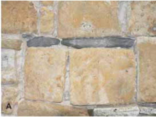
Abb. 85: Posidonienschiefer als Zwischenlage. A Borgholzhausen, Nordseite des Turms der Burg Ravensberg, zwischen Kleinquadern aus Osning-Sandstein des Gebietes zwischen Oerlinghausen und Borgholzhausen, um 1100. B Werther, ev. Pfarrkirche St. Jacobus, Strebepfeiler an der Nordseite, zwischen Werksteinquadern aus Osning-Sandstein des Gebietes zwischen Oerlinghausen und Borgholzhausen 14. Jh., erneuert 1743.
