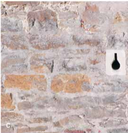
Abb. 66: Turbiditische Bruchsteine des Vorhelm-Members, Ahlen-Formation. A, C, E Herbern, Schloss Westerwinkel, A Westseite nordwestliches Eckbastion, 1663-1696, C Mauerwerksausschnitt, E turbiditischer Bruchstein des Vorhelm-Members, B, D Ascheberg, Haus Romberg, B Torhaus, 1618, C Sockel Torhaus, Tor- und Fenstergewänder sowie Schießscharten Baumberger Sandstein.
