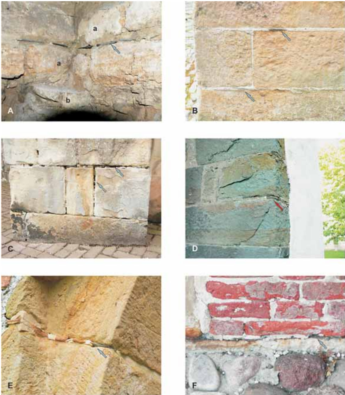
Abb. 88: Schieferplatten als Zwischenlagen.
