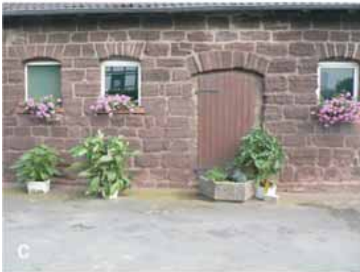
Abb. 24: Gault-Sandstein. A-B Lichtenau, kath. Pfarrkirche St. Kilian, frühes 14. Jh., Turm-Südwestecke, A Untergeschoss, B Wandausschnitt, C-D Herbram, Ackerbürgerhaus Iggenhausener Straße 3, erbaut 1911, C Anbau Nordseite, D Detailsicht. a Gault-Sandstein, b Osning-Sandstein des Eggegebirges, c Plänkalksteine der Baddeckenstedt-Formation, Wambel-Member.
