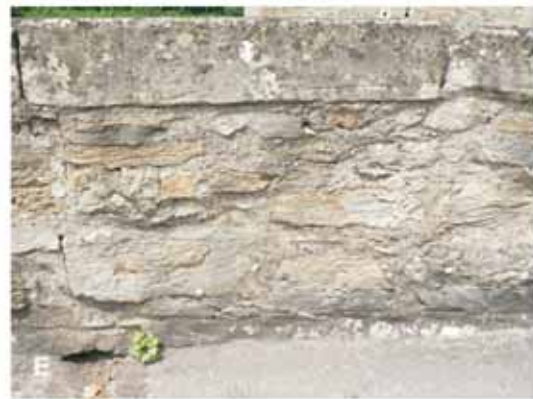
Abb. 66: Turbiditische Bruchsteine des Vorhelm-Members, Ahlen-Formation. A, C, E Herbern, Schloss Westerwinkel, A Westseite nordwestliches Eckbastion, 1663-1696, C Mauerwerksausschnitt, E turbiditischer Bruchstein des Vorhelm-Members, B, D Ascheberg, Haus Romberg, B Torhaus, 1618, C Sockel Torhaus, Tor- und Fenstergewänder sowie Schießscharten Baumberger Sandstein.
