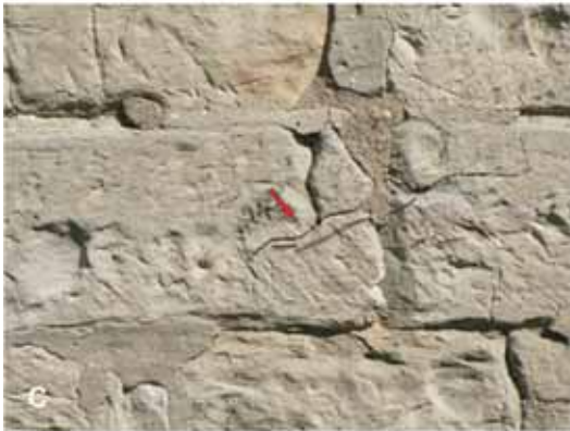
Abb. 45: Plänerkalksteine der Erwitte-Formation, Unterconiacium. A-C Geseke, kath. Stiftskirche St. Cyriakus, südl. Lang- und Querhaus, 13. Jh., A Gesamtansicht, B Ausschnitt Mauerwerk, C Detailansicht Quader des Kreuzgangs, D Salzkotten, Brunnenhaus der Unitas-Quelle, 1554, Gesamtansicht Abb. 76 B, a Plänerkalksteine der Erwitte-Formation, b Soester Grünsandstein, roter Pfeil: Querschnitte der im Unterconiacium leitenden Muschelgattung Cremnoceramus .
