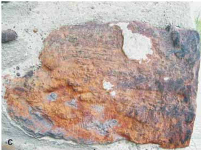
Abb. 35: Sandsteine der Haltern-Formation, kath. Pfarrkirche St. Maria Magdalena, Haltern. A Turm und Langhaus-Südseite, B Strebepfeiler Langhaus-Südseite, C Eisenschwartenstein, Langhaus-Südseite.
