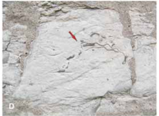
Abb. 45: Plänerkalksteine der Erwitte-Formation, Unterconiacium. A-C Geseke, kath. Stiftskirche St. Cyriakus, südl. Lang- und Querhaus, 13. Jh., A Gesamtansicht, B Ausschnitt Mauerwerk, C Detailansicht Quader des Kreuzgangs, D Salzkotten, Brunnenhaus der Unitas-Quelle, 1554, Gesamtansicht Abb. 76 B, a Plänerkalksteine der Erwitte-Formation, b Soester Grünsandstein, roter Pfeil: Querschnitte der im Unterconiacium leitenden Muschelgattung Cremnoceramus .
