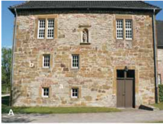
Abb. 61: Turbiditische Bruchsteine des Stromberg-Members, Ahlen-Formation. A Herzebrock, Westseite des Nordflügel des Klosters, u.a. Dormitorium, B Bildausschnitt von A mit Marienstatue, a turbiditische Bruchsteine des Stromberg-Members, b Osningsandstein aus dem Gebiet zwischen Oerlinghausen und Borgholzhausen, c Baumberger Sandstein.
