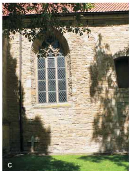
Abb. 56: Kalkarenite der Burgsteinfurt-Formation. A, E Langenhorst, kath. Pfarrkirche St. Johannes d. T., Ende 12. Jh. - 1230, A Südseite mit Südostquerhaus, Südostturm und Chor, E Detailansicht Langhaus-Nordseite, B, D Enschede (NL), Grote Kerk, B romanischer Turm, um 1250, D romanischer Turm, Detailansicht Westseite, C Burgsteinfurt, ev. Große Kirche, Langhaus-Südseite, Ende 14. Jh., a Kalkarenite der Burgsteinfurt-Formation, b Bentheimer Sandstein.
