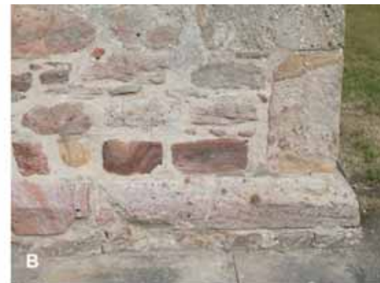
Abb. 81: Ibbenbürener Sandstein. Recke, ev. Pfarrkirche, Anfang 12. Jh., A Untergeschoss der Westseite des Turms, B Detailansicht des rechten Sockels, mittel- bis grobsandige und konglomeratische Variante des Ibbenbürener Sandsteins.
