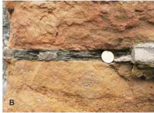
Abb. 85: Posidonienschiefer als Zwischenlage. A Borgholzhausen, Nordseite des Turms der Burg Ravensberg, zwischen Kleinquadern aus Osning-Sandstein des Gebietes zwischen Oerlinghausen und Borgholzhausen, um 1100. B Werther, ev. Pfarrkirche St. Jacobus, Strebepfeiler an der Nordseite, zwischen Werksteinquadern aus Osning-Sandstein des Gebietes zwischen Oerlinghausen und Borgholzhausen 14. Jh., erneuert 1743.
