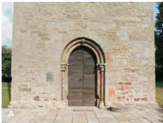
Abb. 81: Ibbenbürener Sandstein. Recke, ev. Pfarrkirche, Anfang 12. Jh., A Untergeschoss der Westseite des Turms, B Detailansicht des rechten Sockels, mittel- bis grobsandige und konglomeratische Variante des Ibbenbürener Sandsteins.
