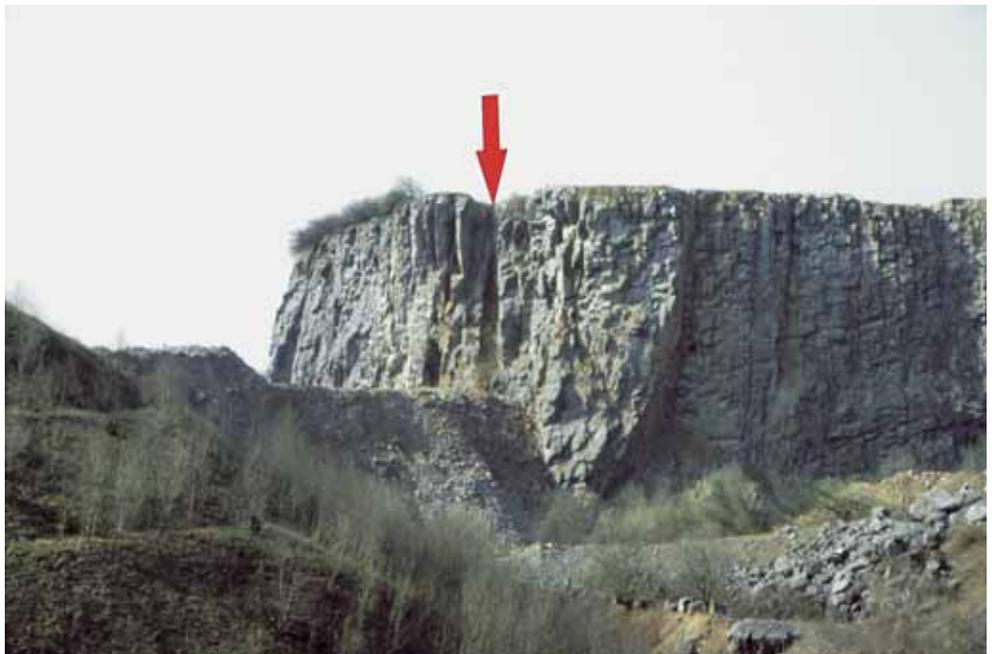
Abb. 2 Nordwand des Steinbruchs Hillenberg mit der Karstspalte (Pfeil). Auf der Rampe (links im Bild) wird die letzte Schicht aufgebracht.
