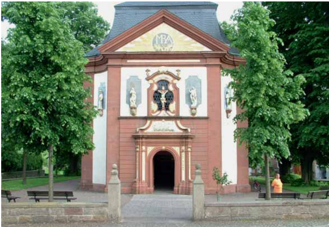
Abb. 36: Wallfahrtskirche in Kleinenberg (1742 – 1758) (Putz- und Natursteinflächen übermalt!)
