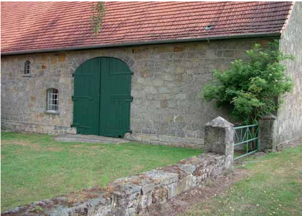
Abb. 17: Stall und Scheune mit Bruchstein-Mauerwerk bei Birgte am nordwestlichen Teutoburger Wald, erbaut 1928 mit Gravenhorster Sandstein aus dem Steinbruch Brumley (4)
