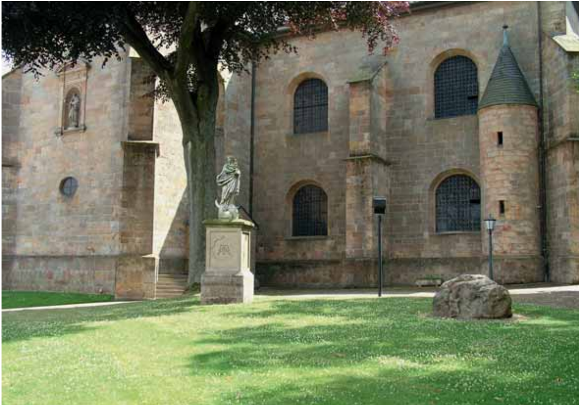
Abb. 35: Kirche St. Vitus in Willebadessen (spätes 12. Jahrhundert, 1720 – 1722 umgebaut)
