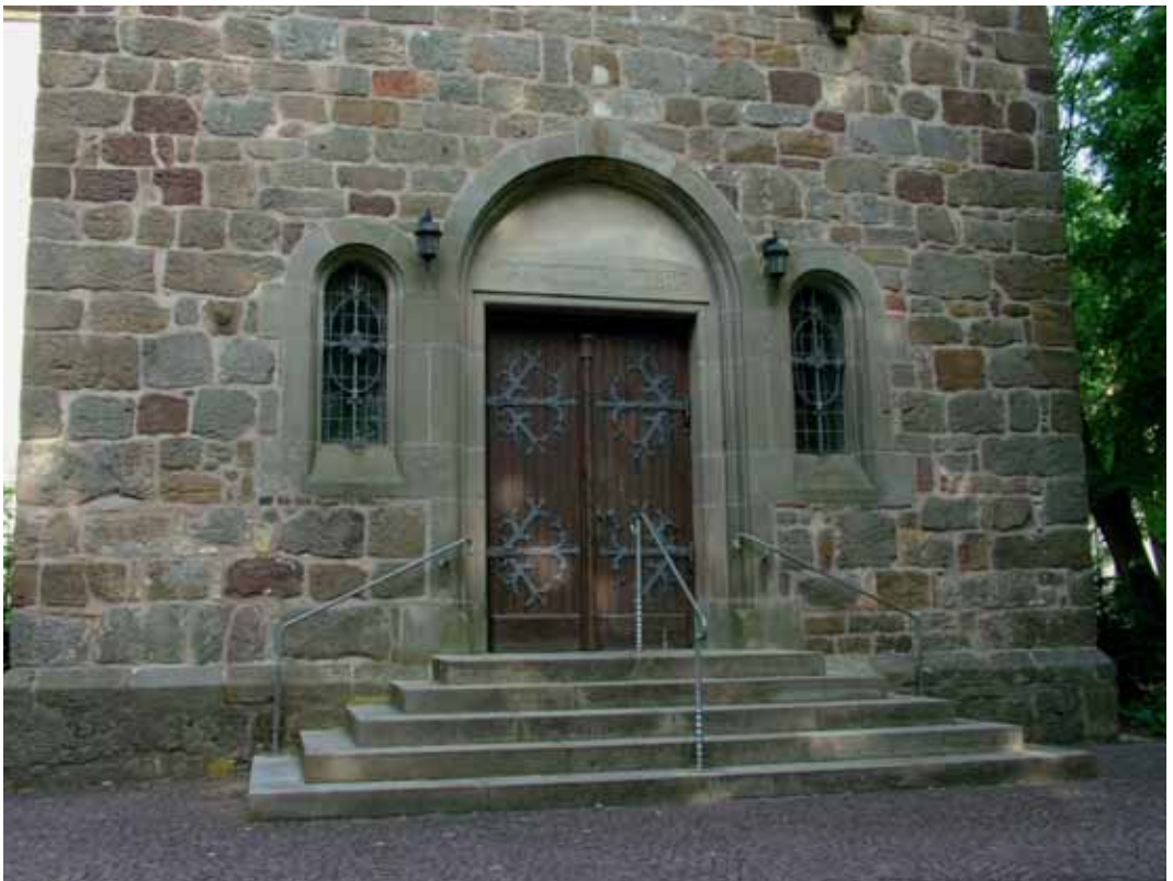
Abb. 24: Turm (Westseite) der Kirche St. Cyriacus in Kleinenberg mit Osning-Sandstein und Gault-Sandstein
