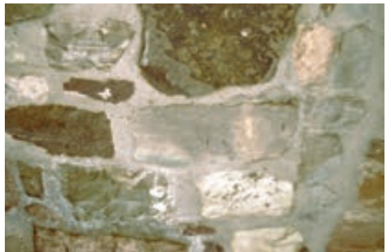
Abb. 39a: Im unteren Teil des Turmes (ca. 5 m) Findlinge, darüber MK IId-Sandsteine; vereinzelt hellgraue MK I-Sandsteine mit Feinschichtung
