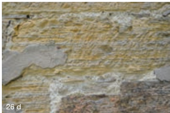
Abb. 26a - 26d: Die gelbbraunen, häufig rostfarbenen Sandsteine zeigen teilweise eine markante Feinschichtung. Gebrochen wurden die Bausteine am Nordfuß des Wurzelbrinks, ca. 1,5 km süd-/ südwestlich der Kirche im Endbereich der Schützenstraße-Verlängerung als Waldweg
