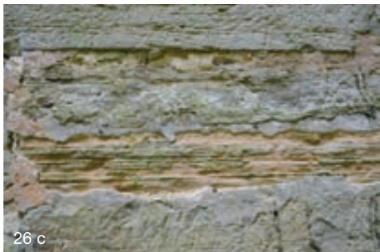
Abb. 26a - 26d: Die gelbbraunen, häufig rostfarbenen Sandsteine zeigen teilweise eine markante Feinschichtung. Gebrochen wurden die Bausteine am Nordfuß des Wurzelbrinks, ca. 1,5 km süd-/ südwestlich der Kirche im Endbereich der Schützenstraße-Verlängerung als Waldweg
