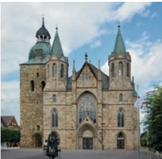
Abb. 38a: Im Turmbereich häufig MK I-Sandsteine (Feinschichtung)
