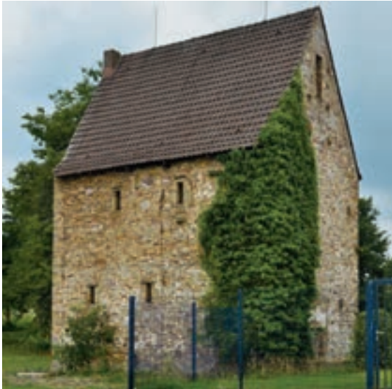
Abb. 62: Ankum: Ehem. Schulte zu Rüssel wohl 2. Hälfte 14. Jahrhundert Probenentnahme und Auswertung durch Preßler & Partner GmbH, Untergerstener Str. 4, 49838 Gersten vom 22.10.2002. Datierung der Hölzer: 1397 \pm 6/1571 \pm 6 (Deckenbalken) und 1721/27 \pm 6 (Dach)
