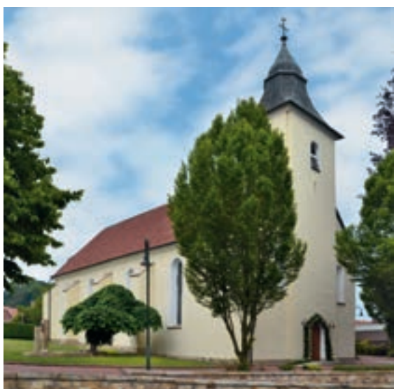
Abb. 54: Schwagstorf: St. Bartholomäus 1264 (verputzt) Turmtreppenbereich: MK Ild-Sandstein
