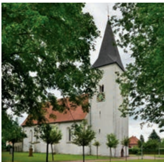
Abb. 55: Ueffeln: St. Marien 1292 (verputzt) Turmtreppenbereich: MK Ild-Sandstein
