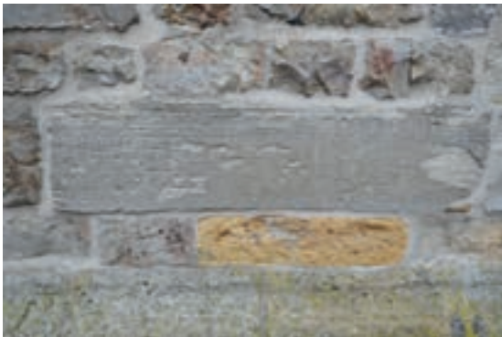
Abb. 38a: Im Turmbereich häufig MK I-Sandsteine (Feinschichtung)
