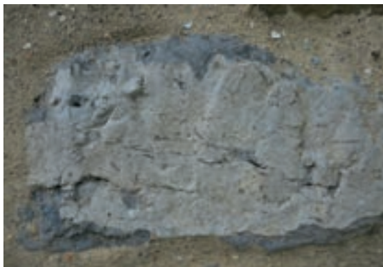
Abb. 44a, 44b: Im basalen Teil des Turmes häufig dunkler, fossilführender Kalkstein (wohl MK III)
