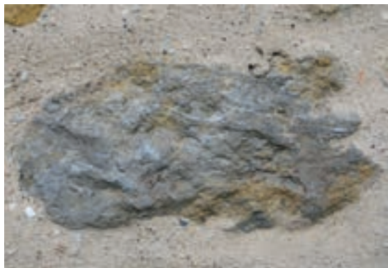
Abb. 44a, 44b: Im basalen Teil des Turmes häufig dunkler, fossilführender Kalkstein (wohl MK III)
