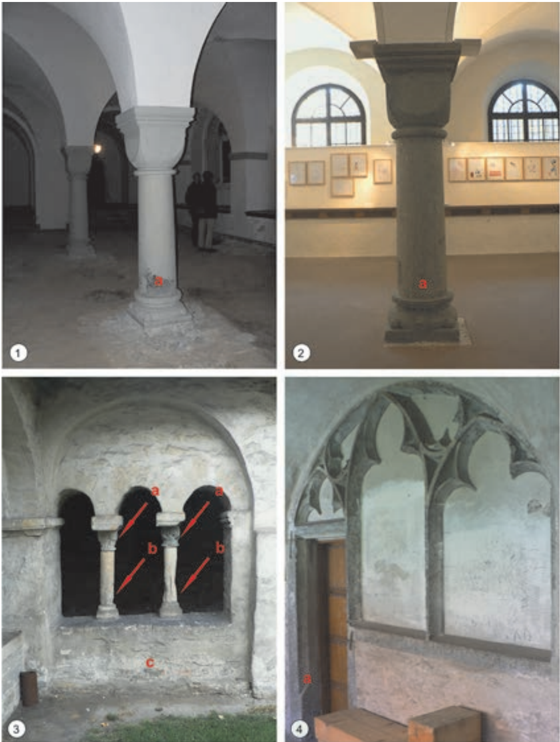
Abb. 43: Soester Grünsandstein in Paderborn: 1 und 2 Kapitelsaal des Doms, 12. Jh., 1 Grabungskampagne um 2006, 2 nach Renovierung; 3 und 4 Kath. Kirche St. Petrus und Andreas, sog. Busdorfkirche, 3 ehemalige Klausur, Nordostecke Kreuzgang, um 1200, 4 Blendmaßwerk Ostflügel des Kreuzgangs, undatiert; a Soester Grünsandstein, b Osning-Sandstein Typ Velmerstot, c Plänerkalksteine der Erwitte-Formation, obere Plänerkalkstein-Einheit.
