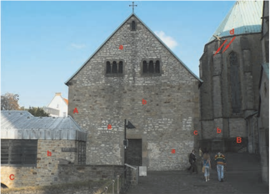
Abb. 32: Paderborn, Am Ikenberg, A Bartholomäus-Kapelle, Westseite, errichtet um 1015 - 1020 zur Zeit des Bischofs Meinwerk, B Kath. Dom St. Maria, St. Liborius und Kilian, Nordquerbau, C Kaiserpfalzmuseum, moderne Eingangshalle (vgl. Abb. 31 f); a Mergelkalksteinquader der Erwitte-Formation, b Mergelkalksteine der Salder-Formation; c Eckquader Osning-Sandstein Typ Velmerstot, d restaurierte Eckquader Osning-Sandstein Typ Grotenburg (19. Jh.).
