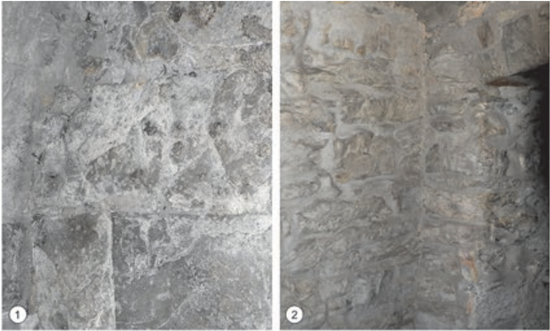
Abb. 38: Paderborn, Kath. Dom St. Maria, St. Liborius und Kilian, Brunnenstube an der Westwand des Nordquerhauses; 1 Bodenplatten, 2 Mauerwerk mit stückigen und grob zugehauenen Plänerkalksteinen der Erwitte-Formation, obere Plänerkalkstein-Einheit.
