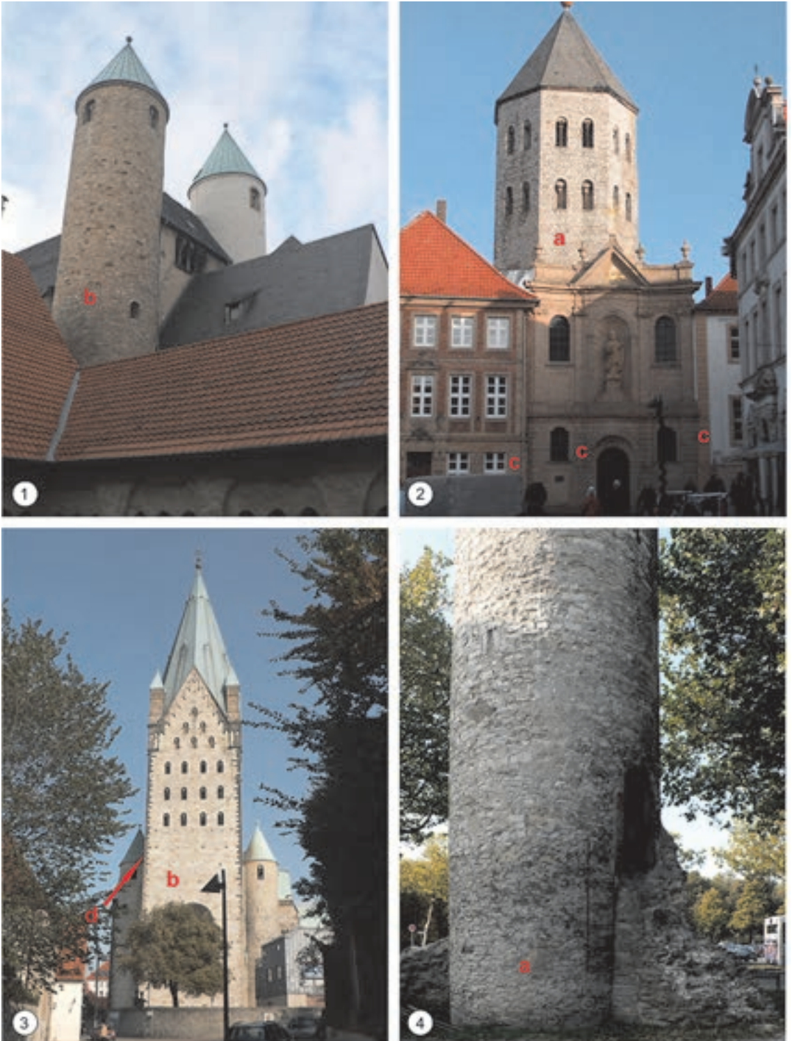
Abb. 34: Plänerkalkstein und Osning-Sandstein im Stadtbild von Paderborn: 1 Kath. Kirche St. Petrus und Andreas, sog. Busdorfkirche, südöstlicher Flankenturm, wiederhergestellt 1964 - 1965; 2 Kath. Kirche St. Ulrich, sog. Gaukirche, um 1170/1180, achteckiger Turm über dem Westjoch vor der Verputzung 2011, Westportal 1746 - 1749; 3 Kath. Dom St. Maria, St. Liborius und Kilian, Westturm, 13. Jh.; 4 Masernturm und Reste der Stadtmauer, ab 12. Jh.; a traditionelle Naturbausteine der Erwitte-Formation, obere Plänerkalkstein-Einheit, b Restaurierung mit Naturbausteinen der Salder-Formation, c Osning-Sandstein Typ Velmerstot, traditioneller Gebrauch, d Osning-Sandstein Typ Grotenburg, Restaurierung des 19. Jh.
