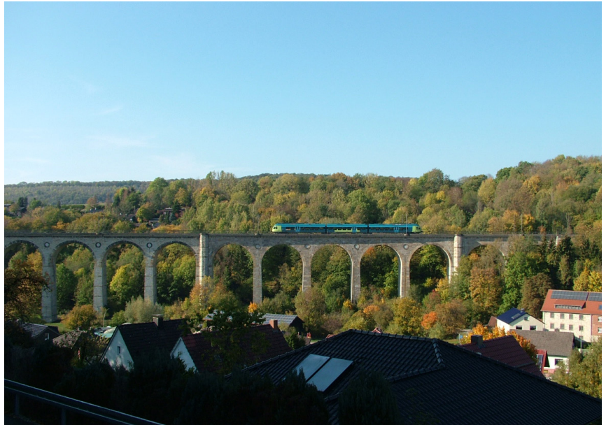
Abb. 9: Der Große Viadukt bei Altenbeken – Ansicht von Süden (Foto: Oktober 2018).
