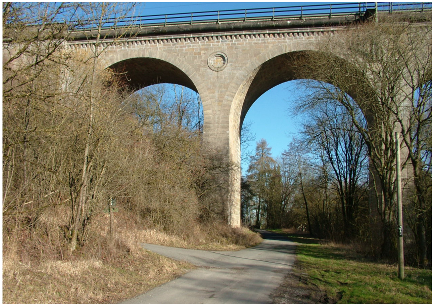
Abb. 7: Der Viadukt im Hellebachtal südwestlich von Willebadessen (Foto: Februar 2019).
