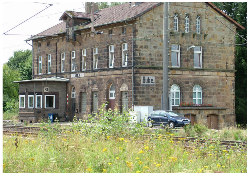
Abb. 11: Der im Jahr 1853 mit Osning-Sand- stein errichtete Bahnhof in Buke südlich von Altenbeken (Foto: August 2008).
