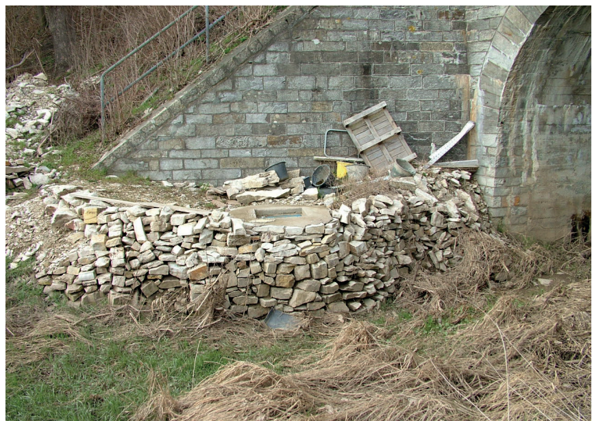
Abb. 10: Gesicherter und ausgebauter Bakenponor im Haxter Grund auf der Westseite der Brücke der alten Warburger Straße über den überwiegend trocken liegenden Ellerbach (März 2021).
