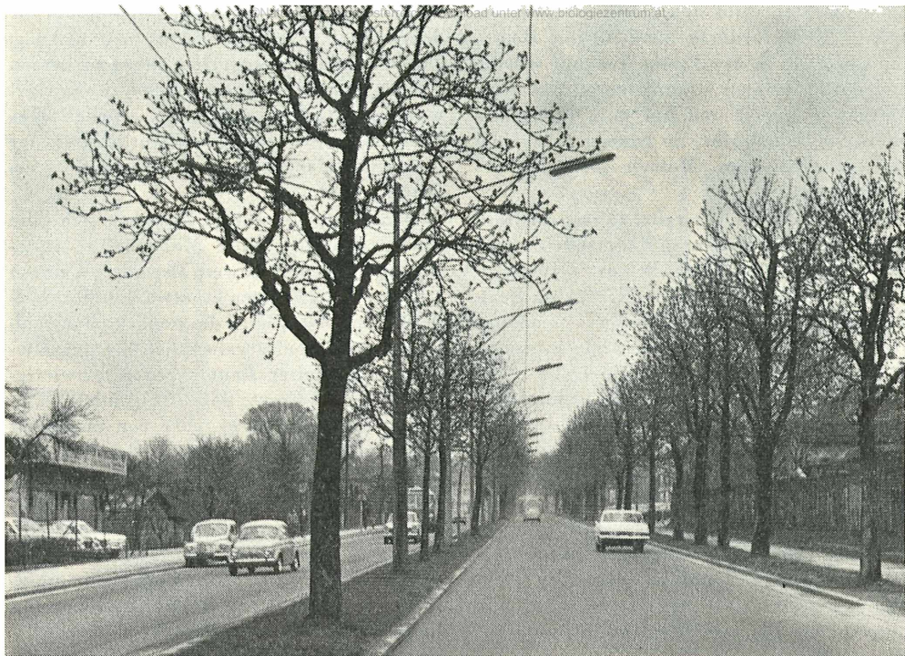
Das Beispiel der Altmannsdorfer Allee in Wien zeigt, daß eine Allee modernen Straßenbau- lösungen durchaus nicht im Wege stehen muß...
