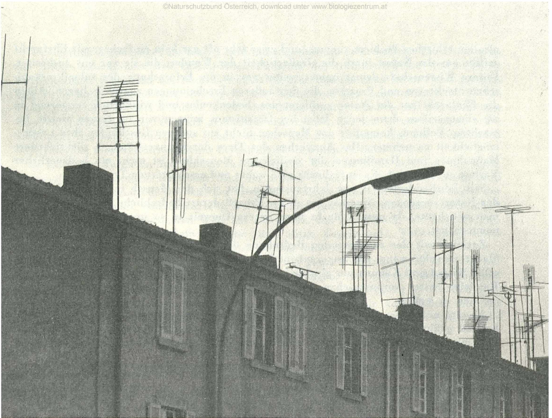
Die neue „Dachlandschaft“
