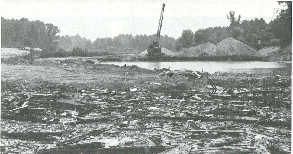
*Bild 2* zeigt in unmittelbarer Nähe der Mülldeponie von Bild 1 einen Baggersee, der mit Bauschutt und Müll mit hohem organischem (also fäulnisfähigem) Anteil aufgefüllt wird. Grundsätzlich bedarf die Anlage eines Baggersees einer wasserrechtlichen Bewilligung, ebenso die Einbringung grubenfremder Stoffe. Diese Bewilligung müsste im sogenannten Wasserbuch ersichtlich sein – was im gegenständlichen Falle nicht zutrifft.
