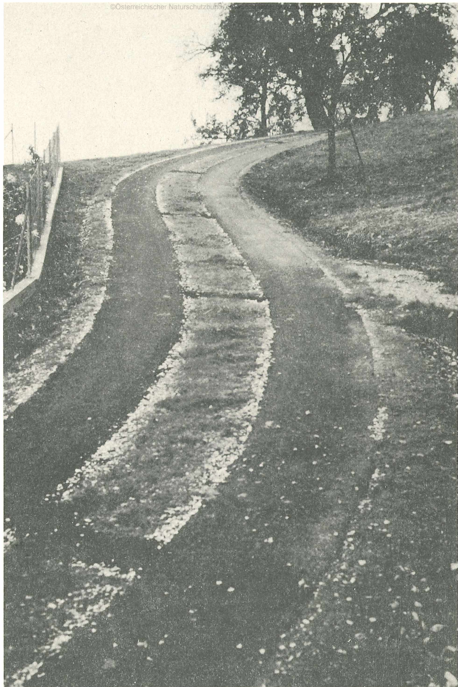
Asphaltspurweg – der »neue Weg«
