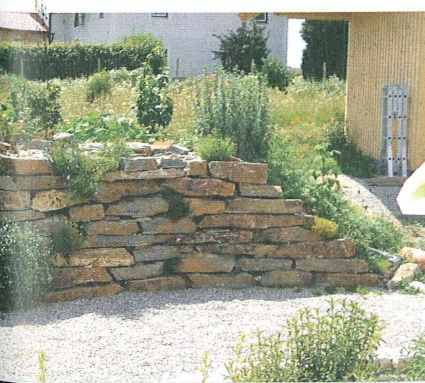
So sollte eine Mauer aufgebaut sein
