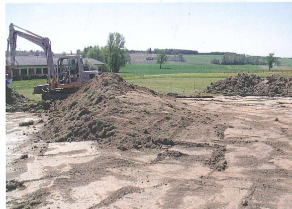
... Zur Ausmagerung wurden 40 cm Oberboden entfernt und durch Schotter, Sand und mageren Unterboden ersetzt ...
