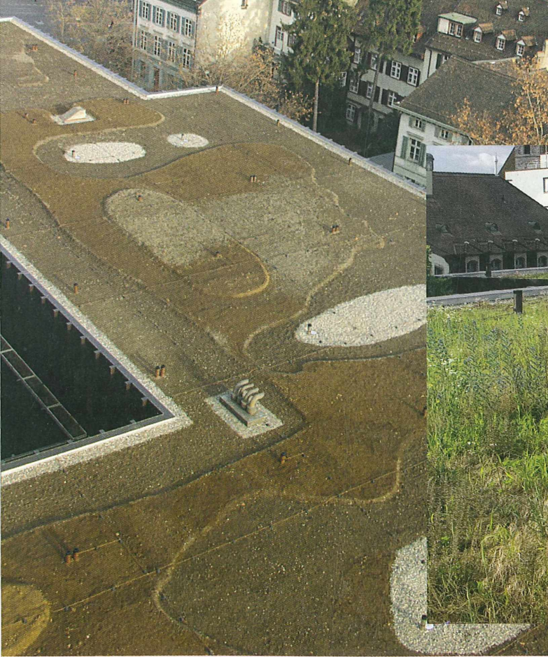
Bilder 2-3: Naturnah eingerichtete Dachbegrünung in Basel links direkt nach dem Anlegen mit unterschiedlichen Bodensubstraten, rechts nach 4 Jahren: Eine artenreiche Dachwiese hat sich entwickelt.
