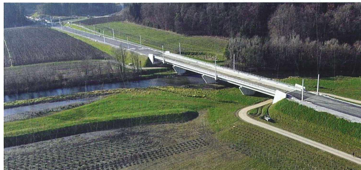
Angewandtes ökologisches Flächenmanagement Koralmbahnstrecke (Kainachbrücke): Vorlandabsenkung an der Kainach im Bereich von Weitendorf zur Schaffung von Überflutungsräumen mit neu angelegtem Flachwasserbereich Fotos © ÖBB/Communicationfactory
