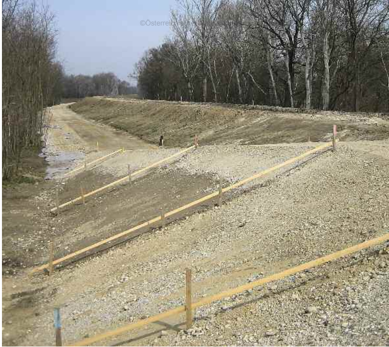
Baustelle des Hochwasserschutzdammes bei Marchegg
