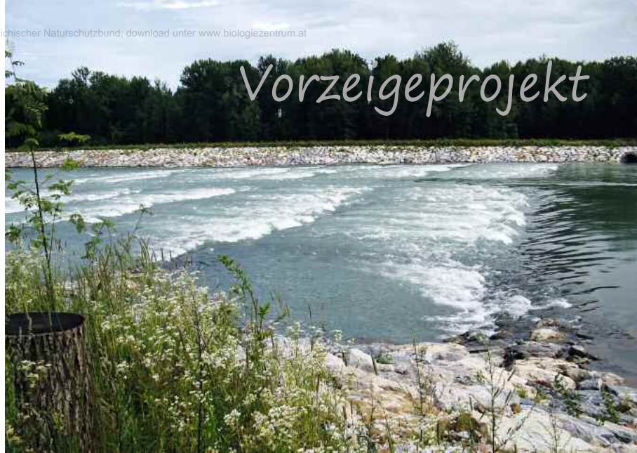
Die „aufgelöste Sohlrampe“ bei Fkm 51,9 – ein technisches Bauwerk als Kompromiss bei der Salzachsanie rung im Freilassing er Becken nördlich der Stadt Salzburg.
