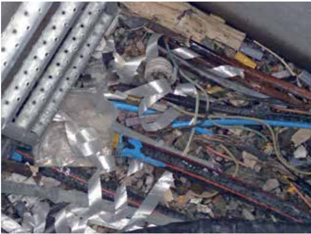
Je mehr Umgänge man unternimmt, umso größer werden die Augen, denn da liegen zwischendurch auch größere Mengen baulichen Abfalls, mit Plastik ummantelte Stahlkabel, direkt am Bachrand und gerade mal 10 m entfernt.
