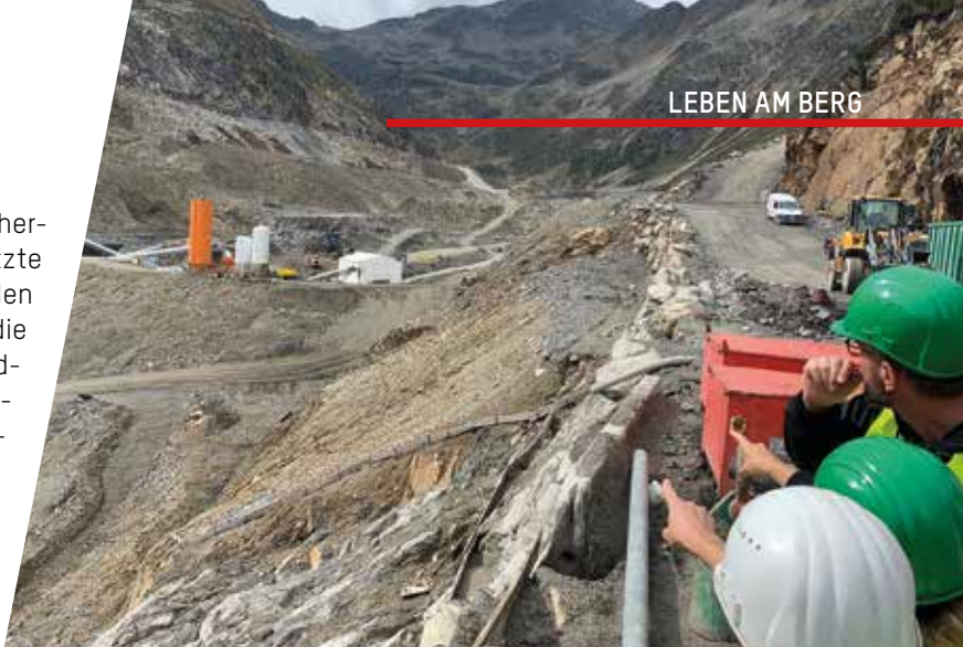
Enorme Eingriffe in den sensiblen Lebensraum Hochgebirge: Baustelle des Staudammes Kühtai, Längental, Tirol
