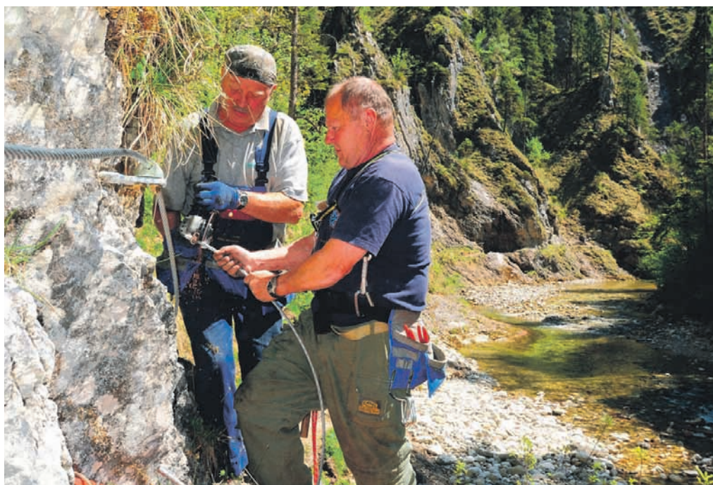
Vom Alpenverein Großraming, unter der Leitung von Wegewart Hermann Garstenauer und Alfred Köthe, wurde der Trifftsteig im Hintergebirge saniert. © Nationalpark/Sieghartsleitner
