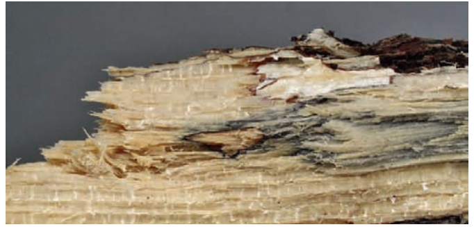
(Abb.: 3) Korrosions- oder Weißfäule
