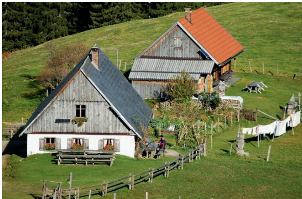
Trotz umfassender Sanierung bleibt die Authentizität der Ebenforstalm erhalten. Foto: NPK/Sieghartsleitner
