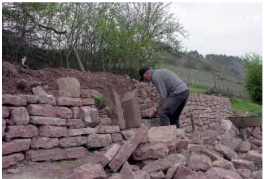
Abbildung 20: Bau einer Trockenmauer
